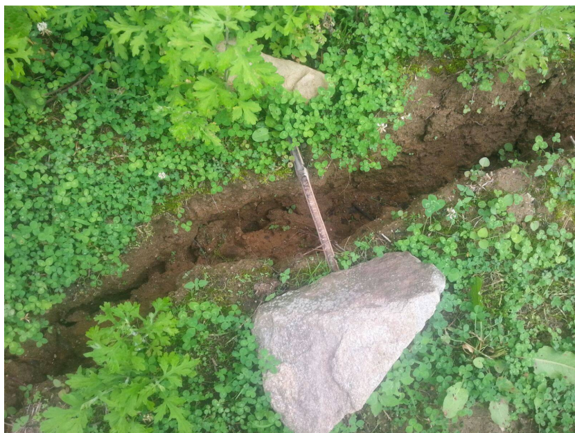
Messung der Risse und Spalten
